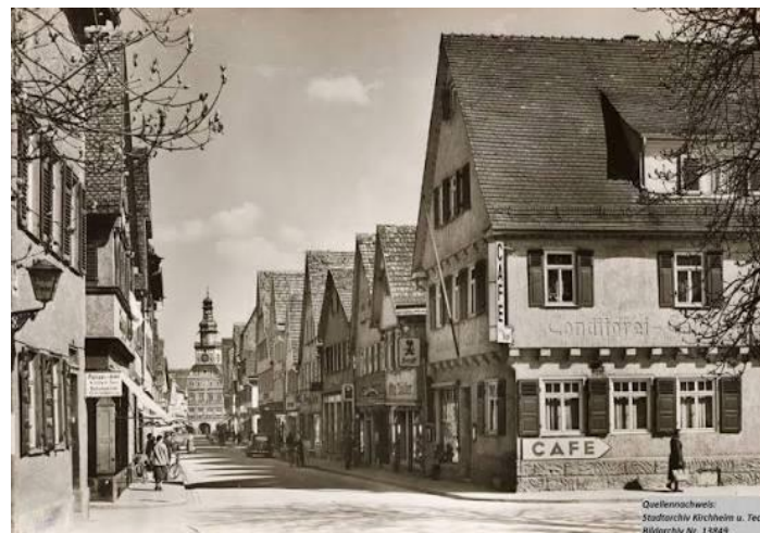
Dieses Foto stammt aus den 1950er Jahren
