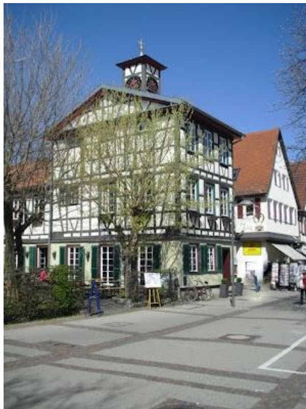
An der Ecke Marktstraße und Alleenstraße befindet sich das Wachthaus. Dies ist das einzige noch erhaltene von ursprünglich vier Wachthäusern, die bei jedem der vier früheren Stadttore standen.
